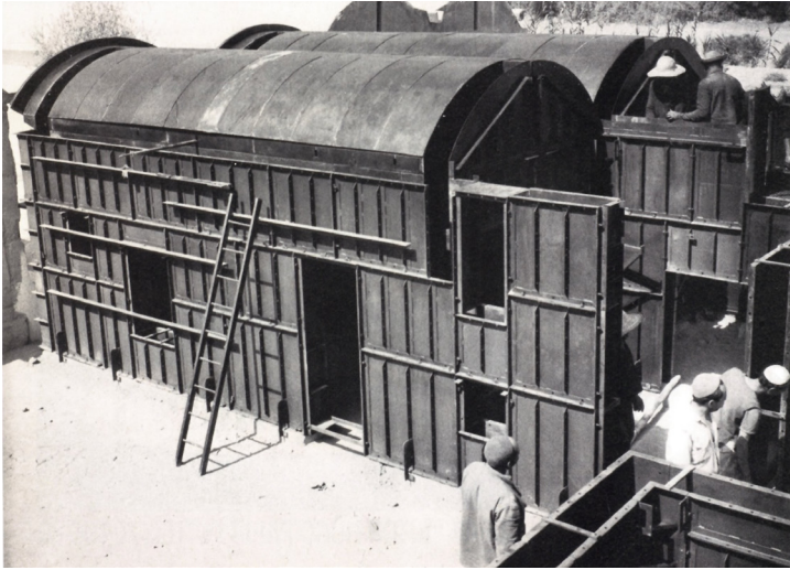
Metal formwork for single house casting using stabilized earth concrete for BTS-67, Ouarzazte, 1967. From Gérard Bauer and Jean Dethier, "La Terre et Le Roseau Ou La Réhabilitation et l'amélioration de Techniques Traditionnelles de Construction Au Maroc," L'Architecture d'Aujourd'hui , no. 160 (1972): 104–11.
